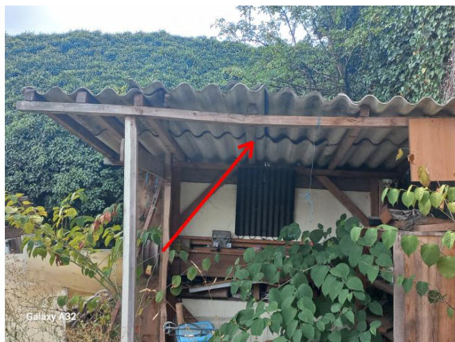
Appentis: ondes en fibrociment
