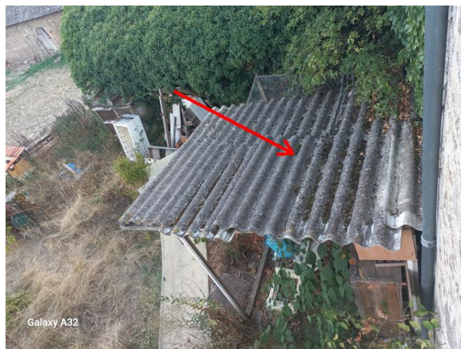
Appentis : ondes en fibrociment
